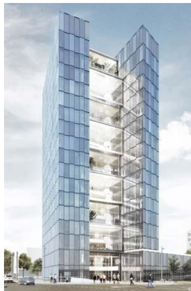
Die neue Unternehmenszentrale von BITZER wird 2018 bezogen.
