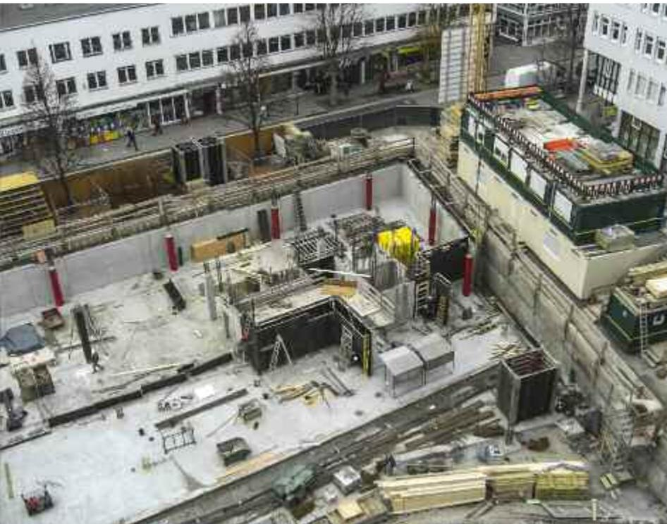
Die gegossene Bodenplatte bietet dem Neubau ein sicheres Fundament.
