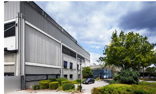
Bürogebäude, Böblingen Herrenberger Straße
