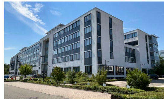
Bürogebäude, Böblingen Schickardstraße
